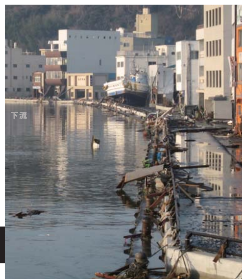
旧北上川河口部：宮城県石巻市 被災状況
