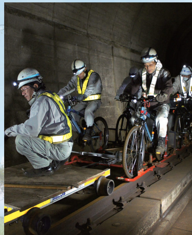
「岩手県のトンネル作業員さん達もガッタン・ゴー」三陸鉄道の小本トンネル内にて
