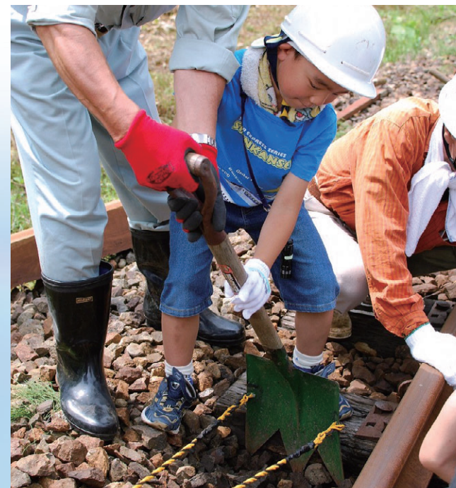
「枕木交換会」年に1回一般公募で行われる傷んだ枕木の交換会
