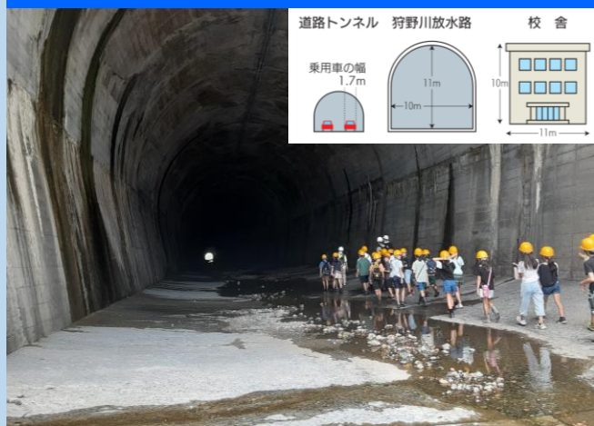
放水路・トンネルの見学
