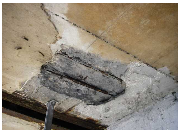
出典：東名高速道路 岡崎IC～豊田JCT間の橋梁劣化状況(中日本高速道路株式会社)
