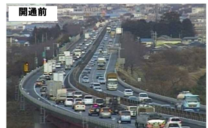
〔東名高速富士川橋付近〕
