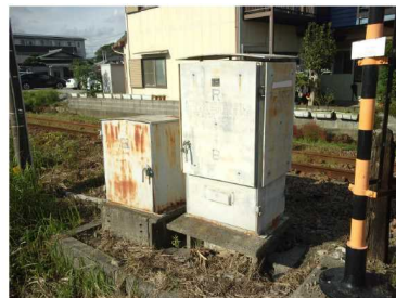
電気設備の浸水対策 踏切保安設備（電源装置）の基礎嵩上
