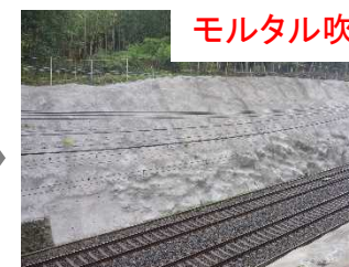
鉄道に隣接する斜面 法面補強工
