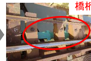
鉄道河川橋りょう 橋桁の補強補修工
