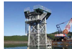
取水設備の整備
