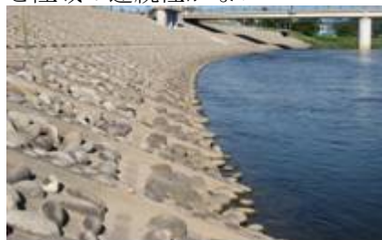
写真 2.1.20 土岐市内の護岸
