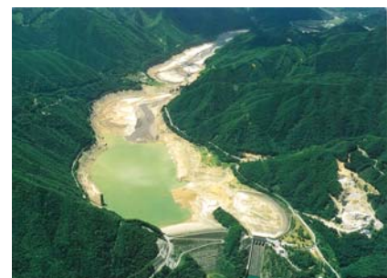
写真 2.1.8 平成6年牧尾ダム（木曽川水系）の枯渇状
