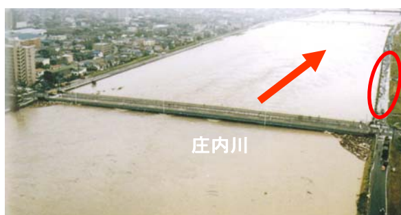
写真 2.1.1 一色大橋右岸の越水状況
