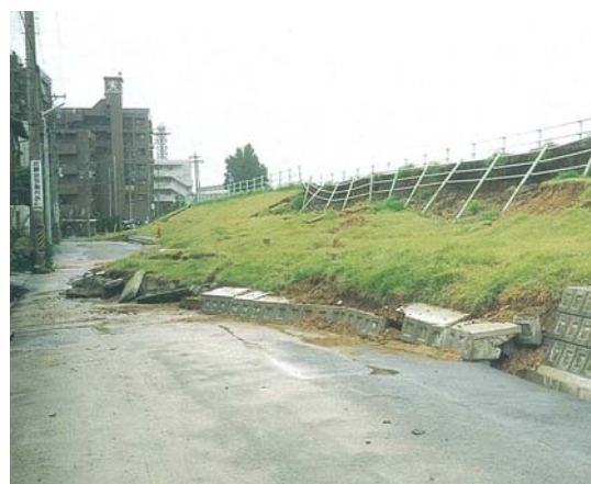
写真 2.1.4 八田川の法崩れの被災状況 (八田川左岸)
