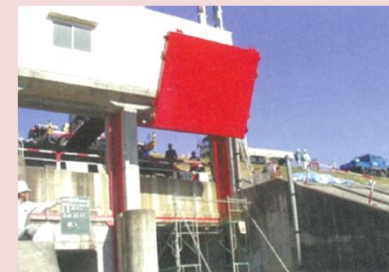
河川管理施設の修繕
