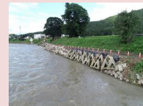
堤防欠損 応急復旧
