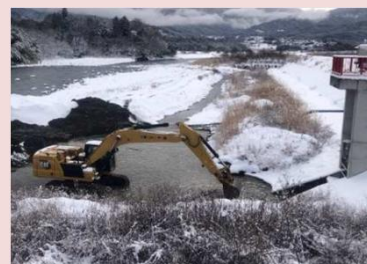
堆積土砂排除
