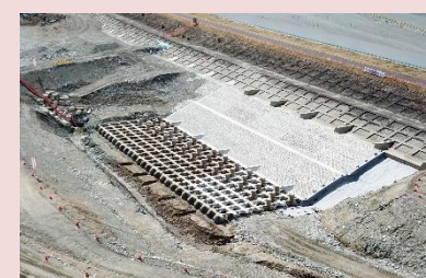
護岸・根固修繕
