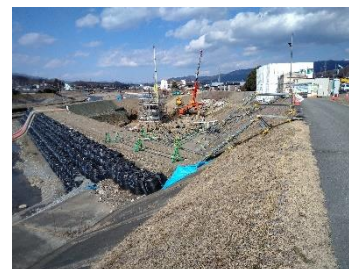
工事の施工状況確認
