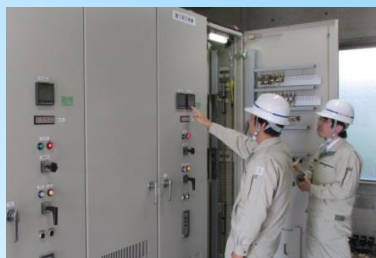
通信設備点検
