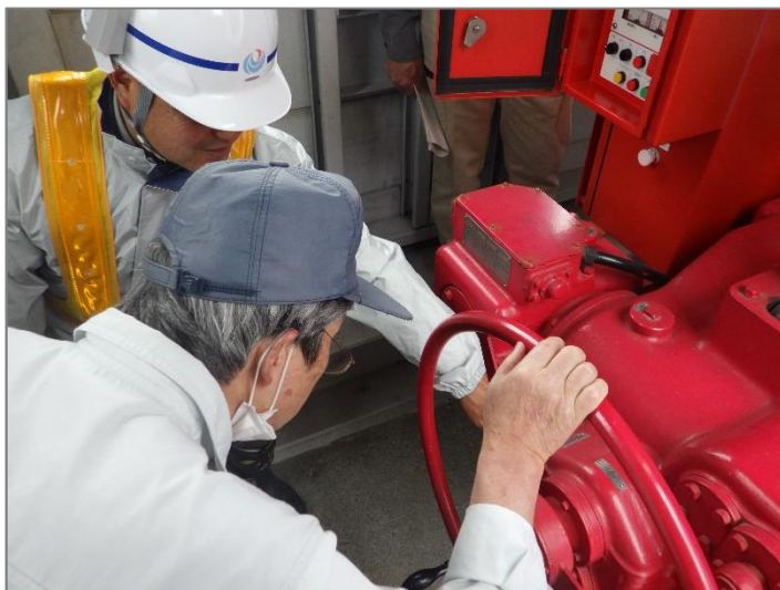
樋門操作講習会の様子（伊那市下新田排水ひ管）
