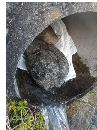
水質事故現地対応の様子 (関係機関によりオイルマットを設置)
